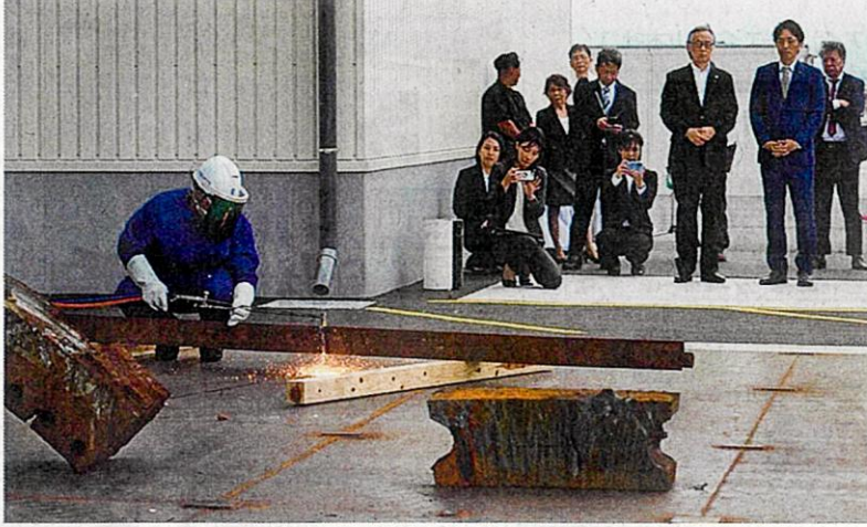
竣工式で実演されたガスバーナーによる切断作業―鳥取県境港市
