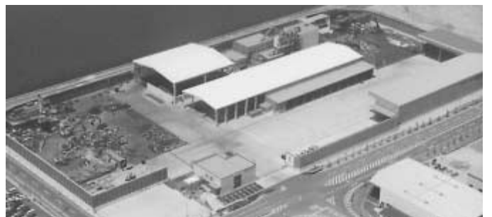
（株）ヒラキノ・リサイクルステージ玉島：2006年（平成18）開設。敷地32,542㎡。1600馬力・本体シュレッダープラント一式及びASR処理ライン一式。1,250t・ギロチンなど。鉄リサイクルの何たるかを知る平林金属が、最新鋭の鉄スクラップ及びダスト処理・選別ノウハウを駆使して作り上げた21世紀型戦略・大型工場である。 倉敷市玉島乙島字新湊8259-17。電話086-525-7117。
